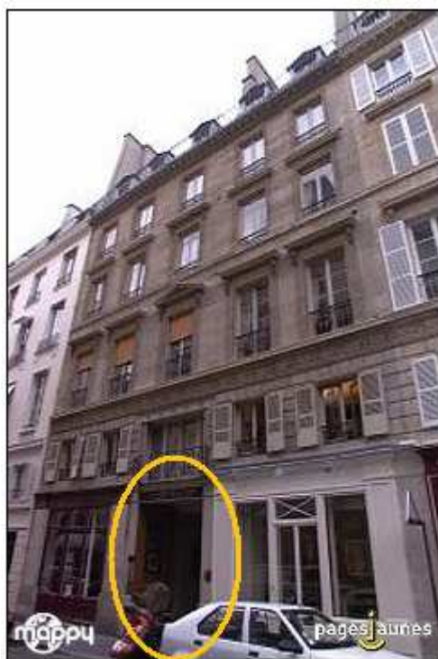
L'entrée du 10, rue de Louvois
